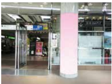
③駅舎入口外柱巻き (直径0.8m)
