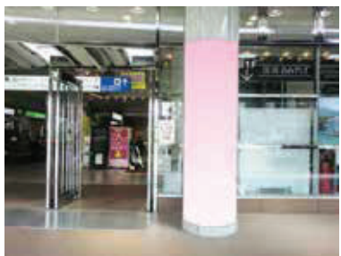
③駅舎入口外柱巻き (直径0.8m)
