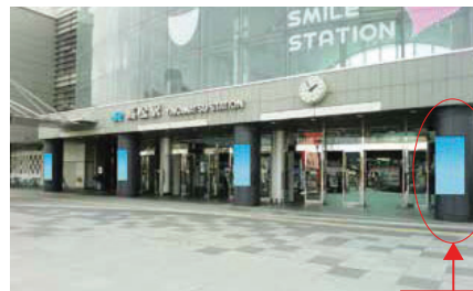
工事支障箇所
