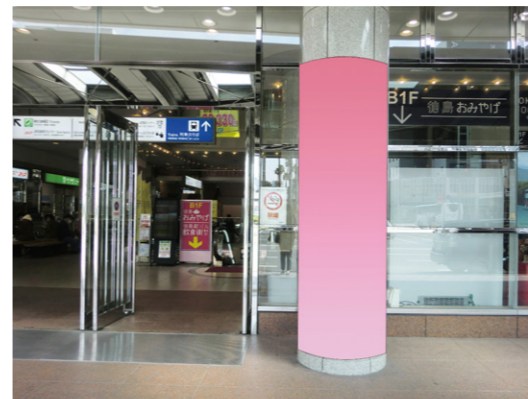
③駅舎入口外柱巻き(直径0.8m)
